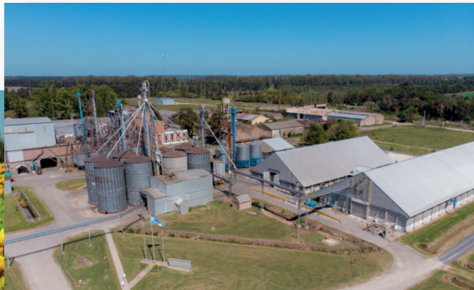
Planta Industrial de proceso Argensun S.A.
